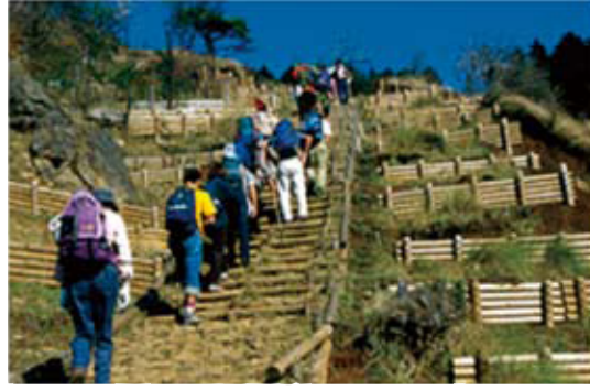
整備後の左写真と同じ場所
