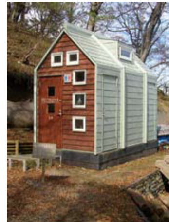
電気も水道もない檜洞丸にあるバイオトイレ。微生物の力でウンチやオシッコを分解します。
