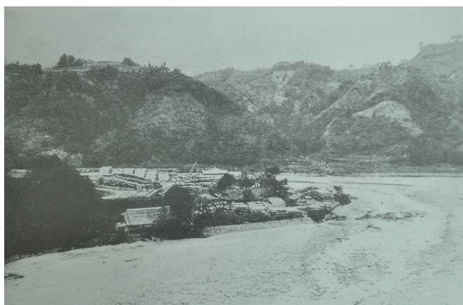
図2 大倉組貯木場写真（『津久井町郷土誌』）
